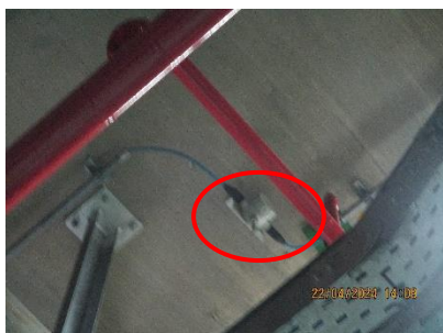
ภาพที่ 2-37 Heat Detector
