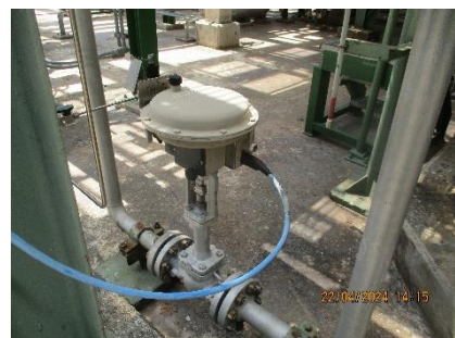
ภาพที่ 2-4 Control Valves
