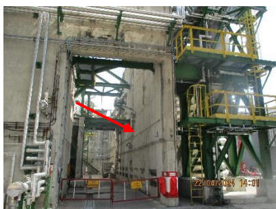
ภาพที่ 2-31 กำแพงกันระเบิด (Blast Proof Wall)
