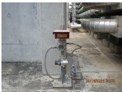
ภาพที่ 2-5 Gas Detector
