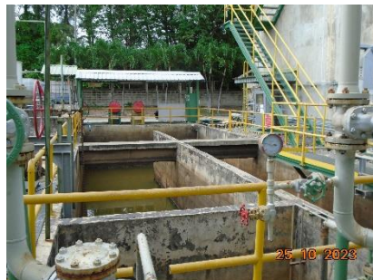
ภาพที่ 2-16 API Separator
