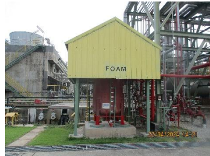
ภาพที่ 2-48 Foam Bladder Tank
