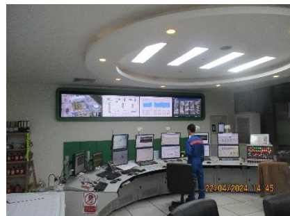
ภาพที่ 2-2 การตรวจสอบ และควบคุมการทำงานผ่าน DCS ที่ CCR
