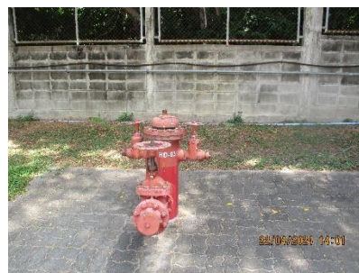
ภาพที่ 2-38 ระบบหัวฉีดดับเพลิงแบบ 2 ทาง
