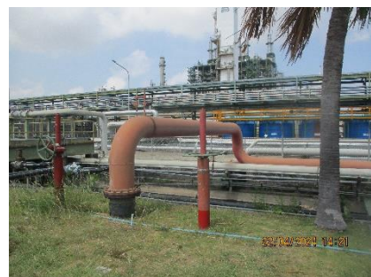
ภาพที่ 2-50 ท่อรับน้ำดับเพลิงจาก PTT GC
