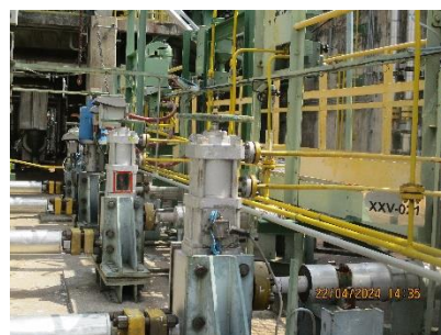
ภาพที่ 2-32 Interlock Valve บริเวณถังปฏิกรณ์
