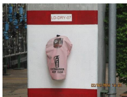
ภาพที่ 2-42 ถังดับเพลิงมือถือชนิดผงเคมีแห้ง
